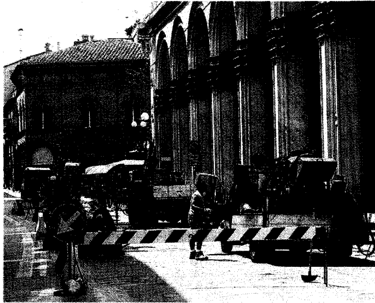
CANTIERI Lavori stradali per il ripristino della pavimentazione di via Farini
